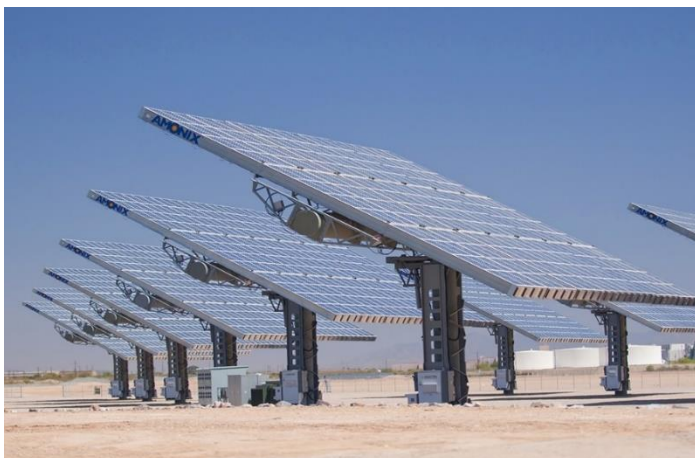
Рис. 1. Солнечная электростанция общей мощностью 35 МВт, площадью 91 га, изготовленная с френелевскими концентраторами и установленная американской компанией “Амоникс”
